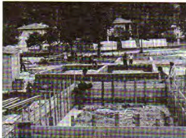
Si approntano i basamenti dei prefabbricati
